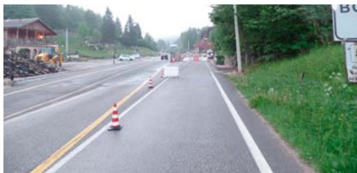
La strada provinciale che porta ad Asiago, nei pressi dell'Hotel Bocchetta è stata "spostata" a sinistra per circa 200 metri. Ora il vecchio manto stradale, opportunamente delimitato da un muro, è entrato a far parte della struttura dell'hotel.
