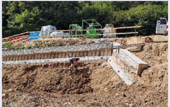
Santa Caterina: un nuovo depuratore è in costruzione tra la strada ed il torrente Grabo.
