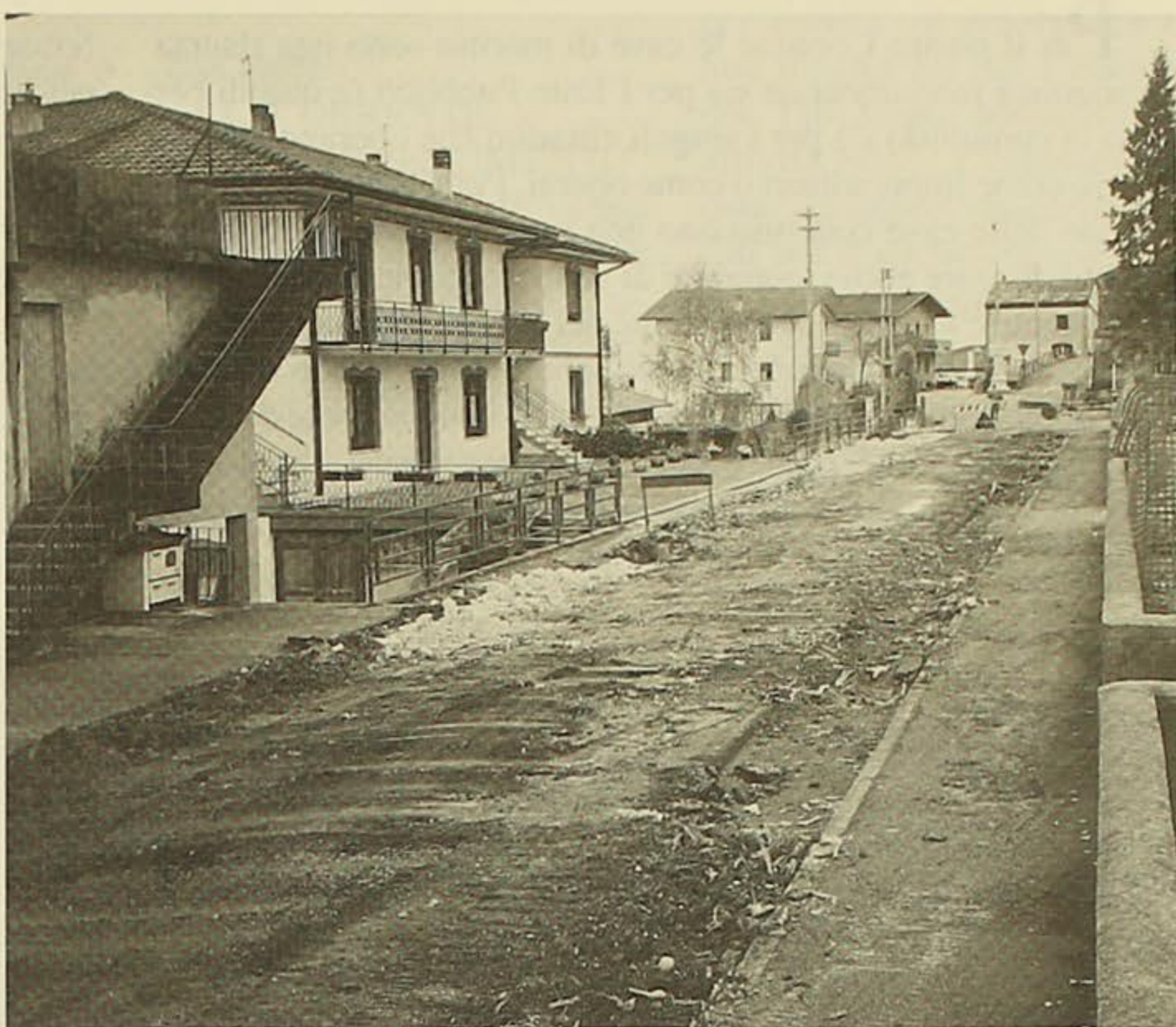
Il viale Marco Poli messo a soqquadro dai lavori.
