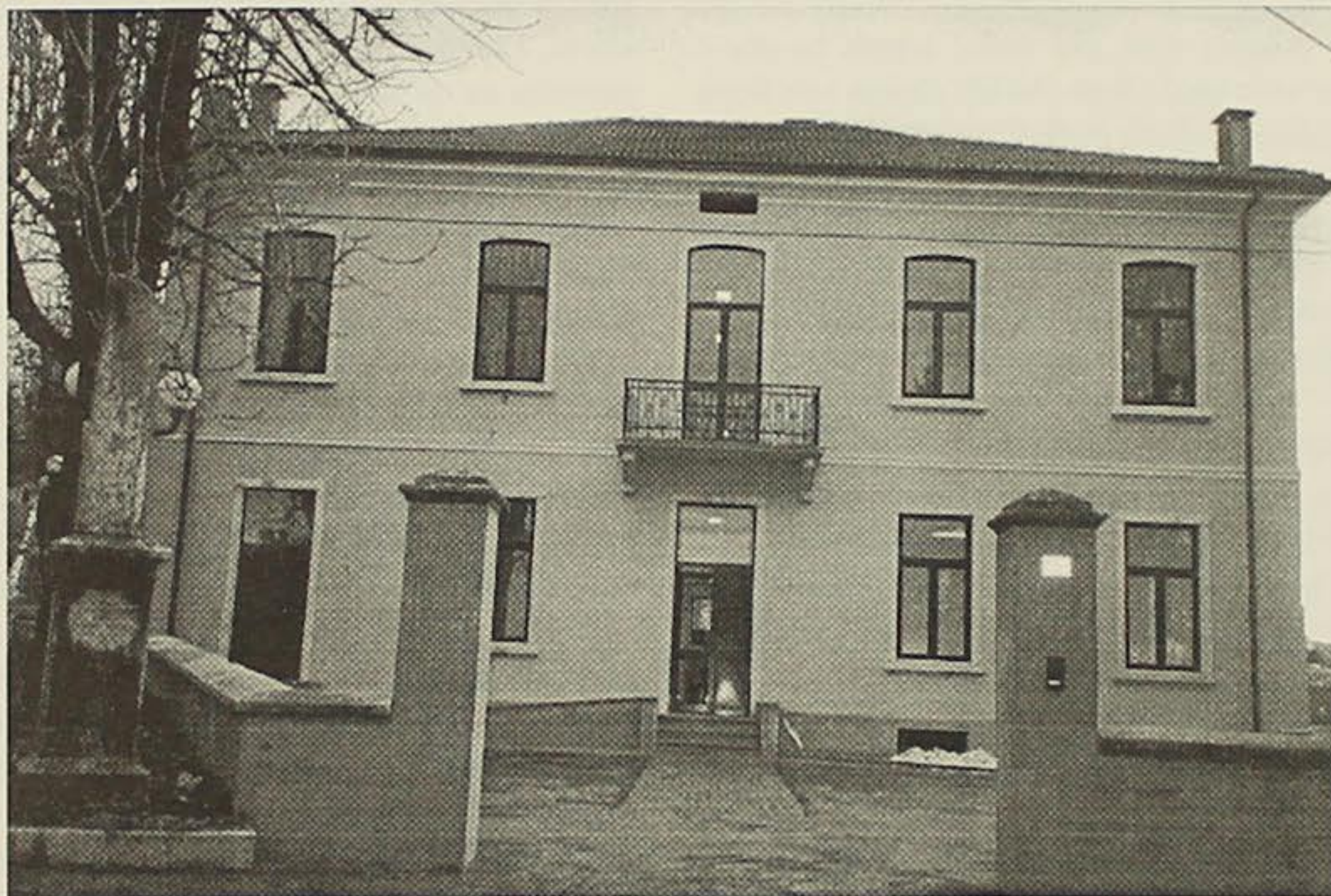
Le vecchie scuole di Conco, rimesse a nuovo con un intervento davvero molto ben riuscito, ospitano nuovamente, dallo scorso 8 gennaio '96, le classi delle Elementari. La chiusura dell'edificio risale al 1990.
