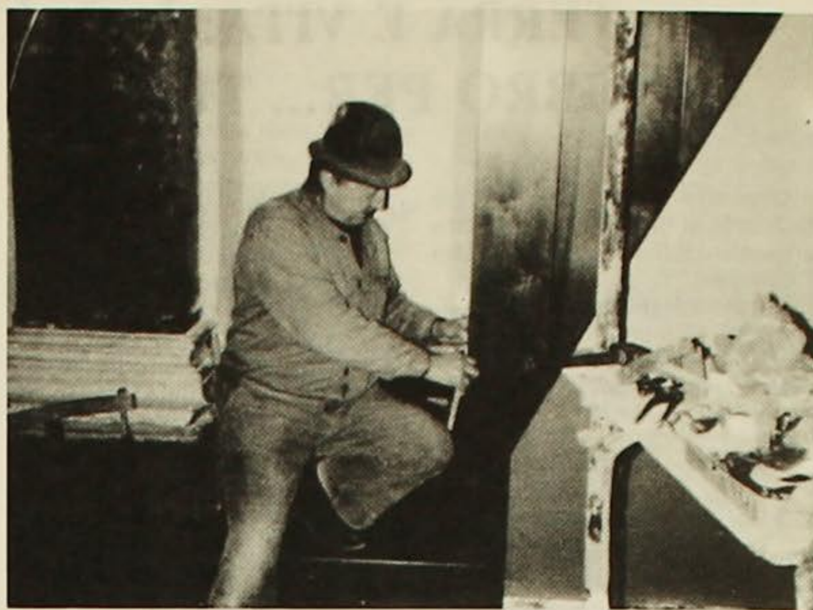
Il falegname Mario Cortese sta finendo di montare la scala di accesso al soppalco per l'organo.
