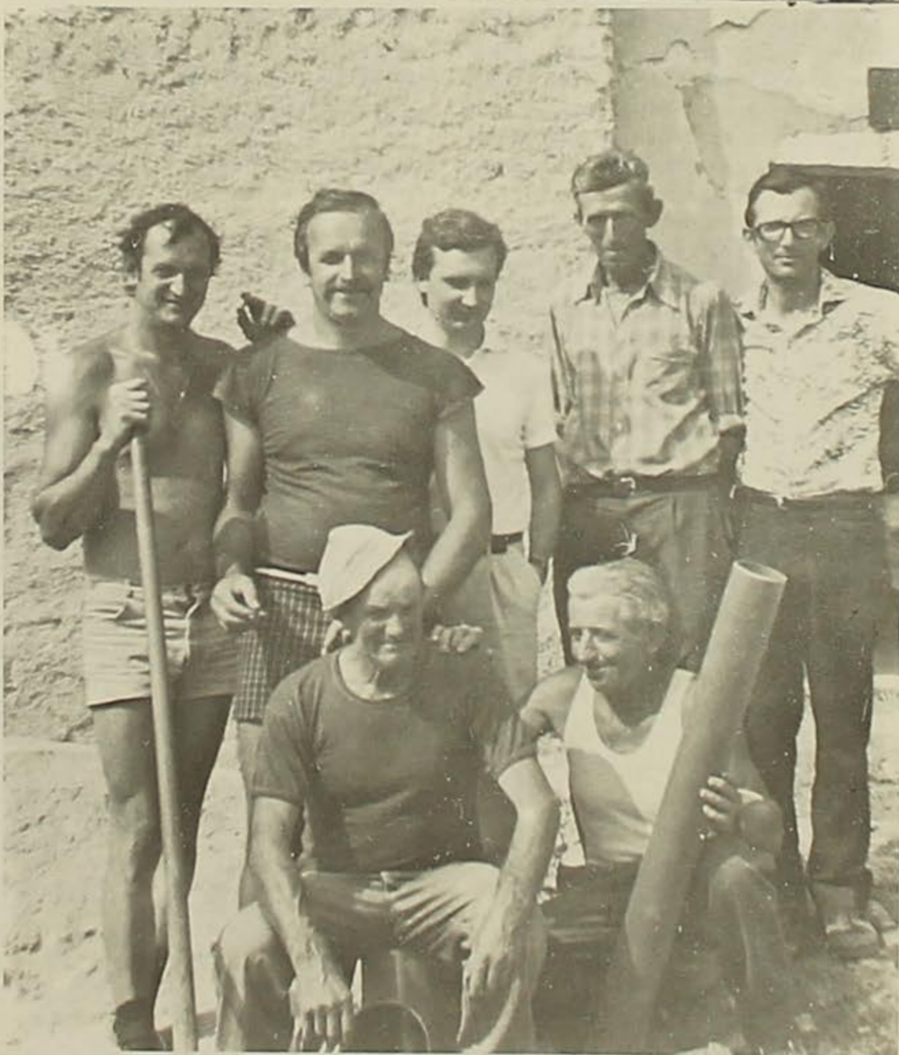
Contrà Alto: le fognature sono importanti. Il Comune mette il materiale, uno scavatore meccanico e due stradini; la Contrà partecipa ai lavori con la manodopera gratuita dei suoi uomini. Il lavoro è quasi finito ed il tecnico con le geom Galvan pose assieme ai "prestatori d'opera", per una foto ricordo.
