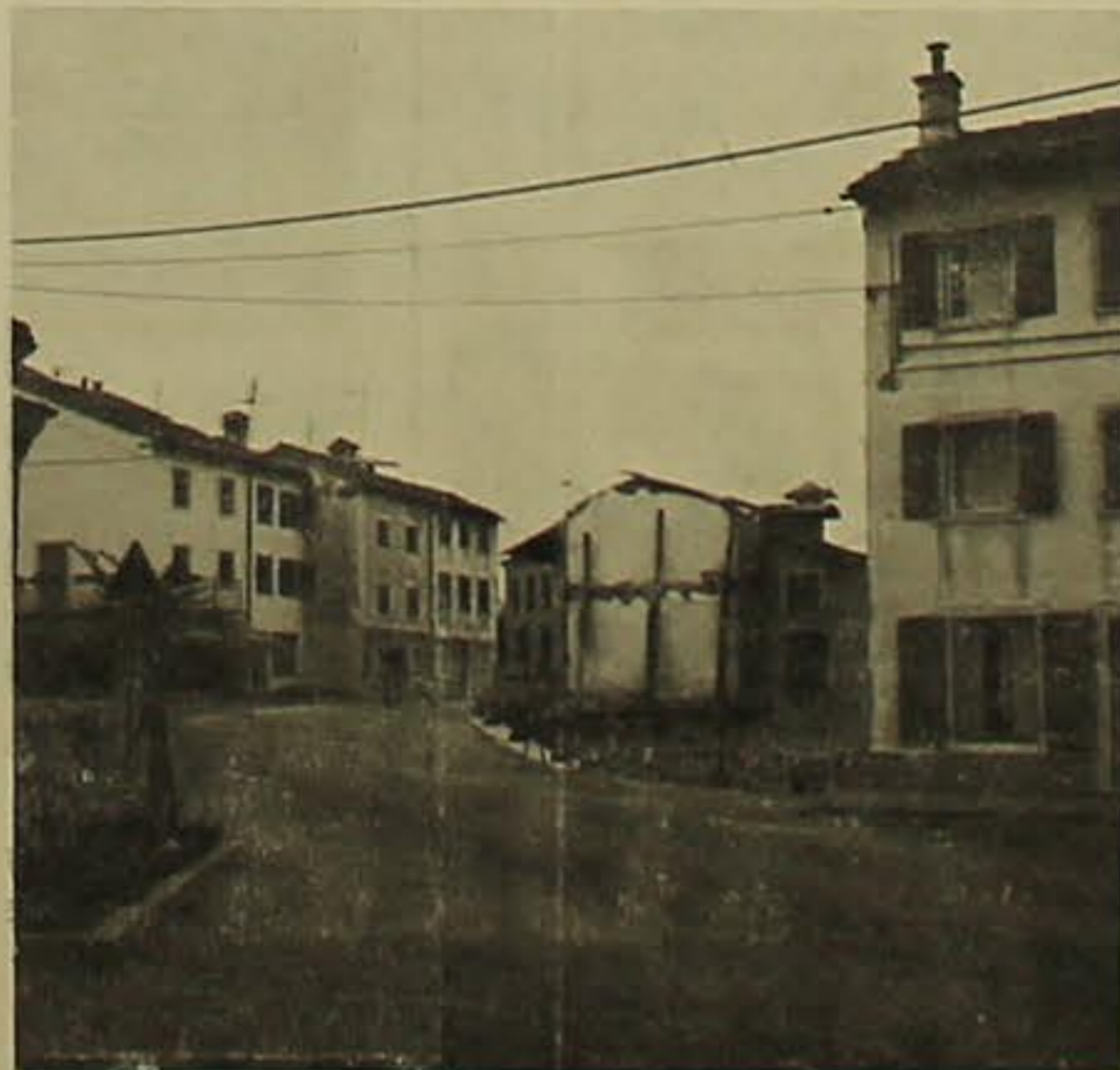
Lavori di ampliamento della strada provinciale nel centro di Conco. Ecco come si presenta ora la curva che «esce» dalla piazza e va verso Conco di Sopra, dopo l'abbattimento delle case Pasini-Pilati.
