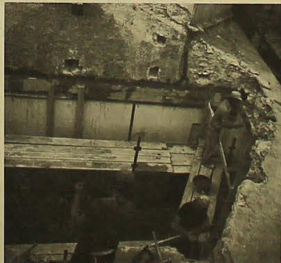
Gli operai hanno rimosso il tetto della Sacrestia per il rifacimento
